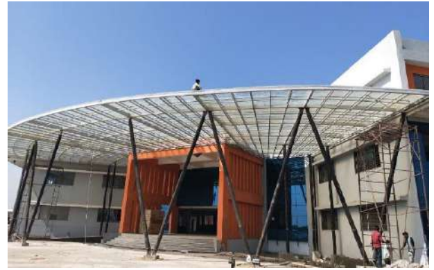
देसर में प्रशासन भवन, लड़कों और लड़कियों के छात्रावास
