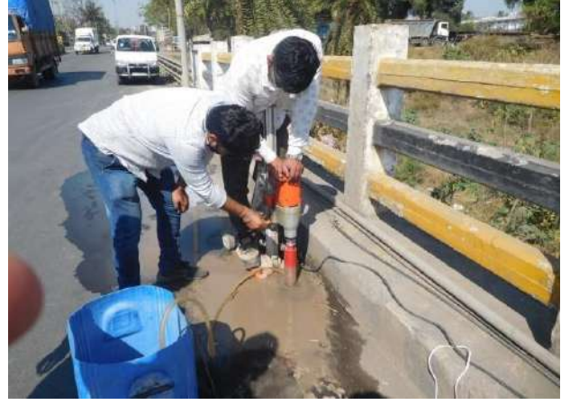
सिलवासा में राखोली पुल पर गैर-विनाशकारी परीक्षण
