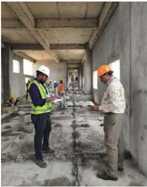
अतिरिक्त प्रदर्शनी और कन्वेंशन हॉल टीएनटीपीओ, तमिलनाडु का निर्माण
