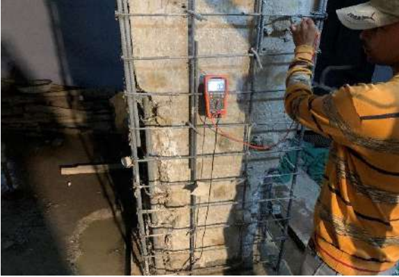
द्वारका, नई दिल्ली में एनएचएआई आवासीय एन्क्लेव की साइट पर जिक एनोड की स्थापना के बाद निरंतरता परीक्षण किया जा रहा है
